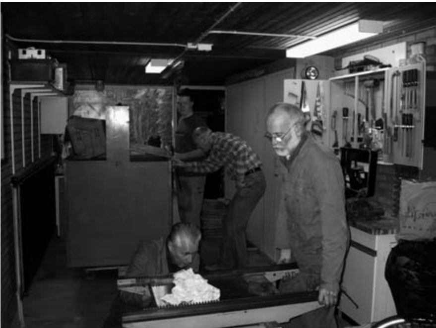
Op de achtergrond werkoverleg tussen vader & zoon over de verbouwing van de bok. Op de voorgrond plaatsen Tjitze en Chris het geslepen fundament op de pers.
