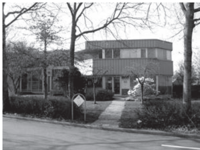
Ingang nieuwe behuizing
