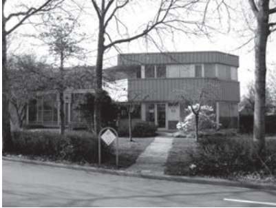
Ingang nieuwe behuizing
