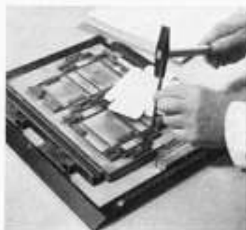
Kleine onderbrekingen in de stansmessen voorkomen, dat het stanswerk aan de vorm blijft hangen of in de machine valt.
