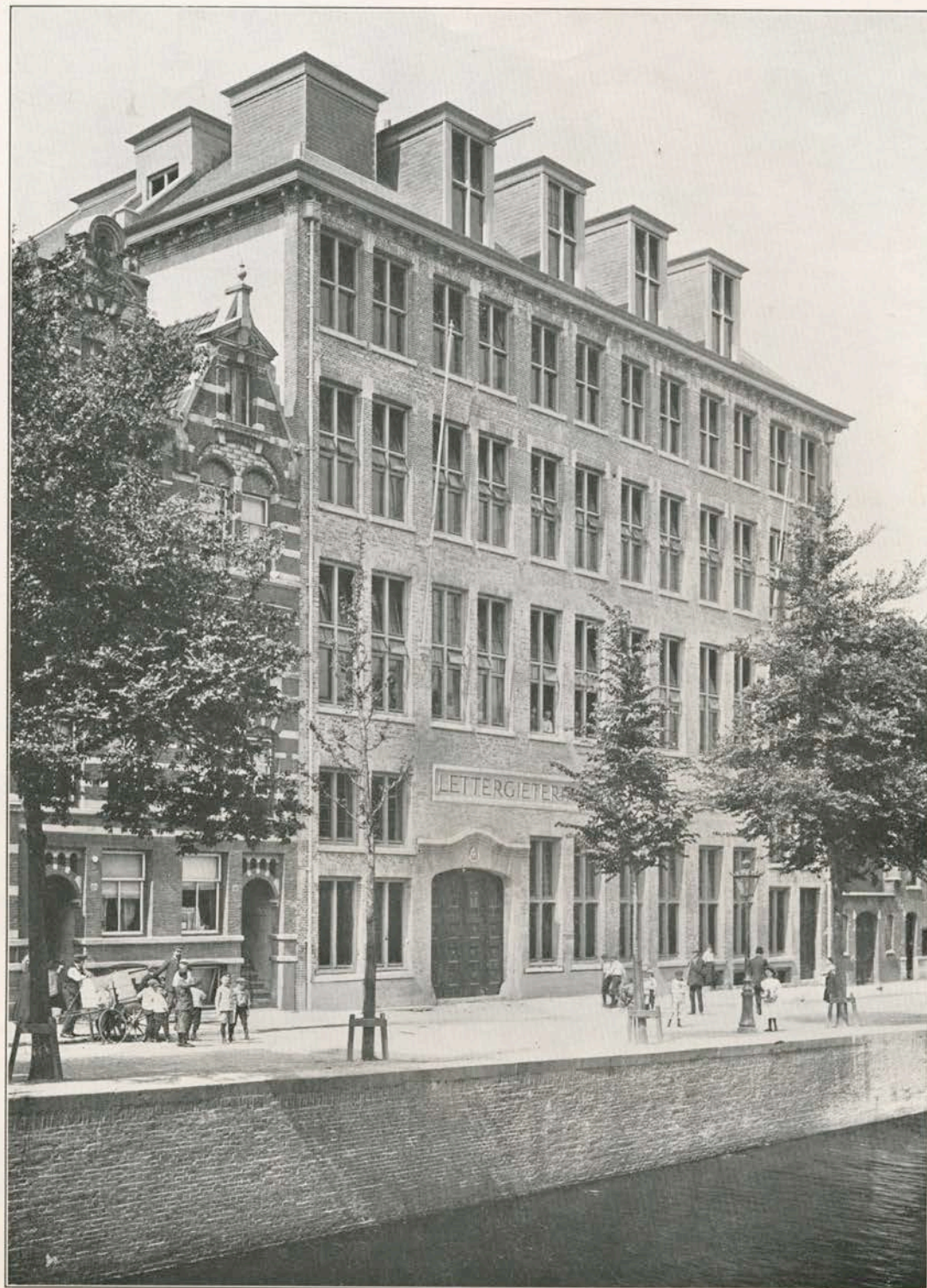
ONS FABRIEKSGEBOUW DA COSTAKADE 158-164 TE AMSTERDAM, IN WELKS TWEE BOVENSTE ÉTAGES DE IN DEZE PRIJSCOURANT AFGEBEELDE MEUBELN WORDEN VERVAARDIGD
